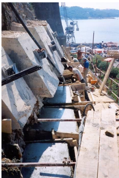
Sidreni blokovi ispod upornjaka mosta u Dubrovniku, 2001.
