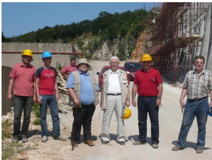
Gradilište Hidrokreking, Urinj 2010.
