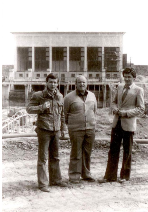
Crpna stanica Migalovci, 1979.
