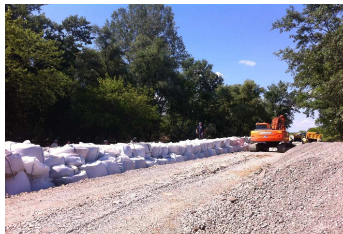
Početna faza izgradnje zagata u Rajevom selu jumbo vrećama
