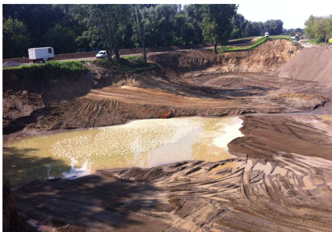
Rajevo Selo - početak sanacije proboja savskog nasipa
