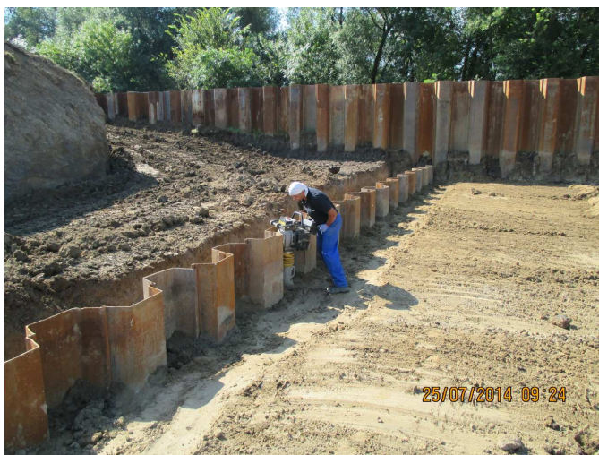
Ugradnja talpi s obalne strane proboja nasipa u Račinovcima
