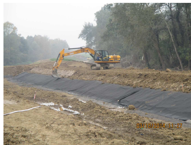
Sanacija nasipa na lokaciji odrona izvođenjem „sendvič” konstrukcije
