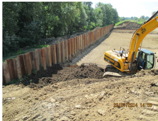
Ugradnja talpi s obalne strane proboja nasipa u Račinovcima
