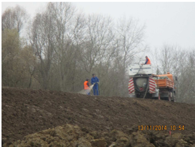
Račinovci – hidrosjetva
