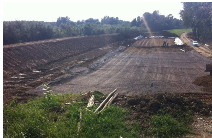
Račinovci - sanacija nasipa na mjestu odrona, lijevo – privremeni nasip
