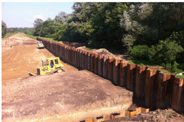
Ugradnja talpi s obalne strane proboja nasipa u Račinovcima
