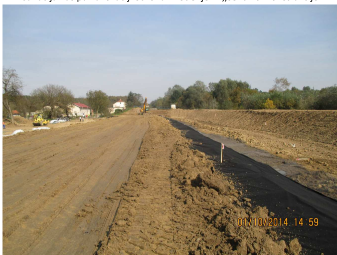
Sanacija nasipa na lokaciji odrona izvođenjem „sendvič” konstrukcije
