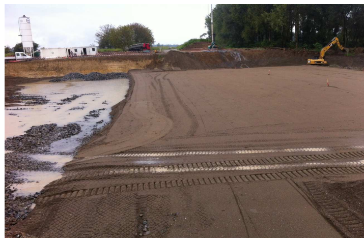
Rajevo Selo - ugradnja šljunčanih slojeva ispod budućeg nasipa
