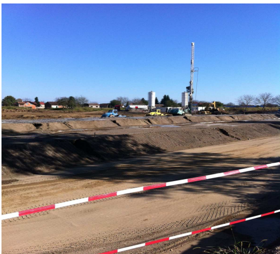
Rajevo Selo - ugradnja vodonepropusne zavjese od betonskih stupnjaka
